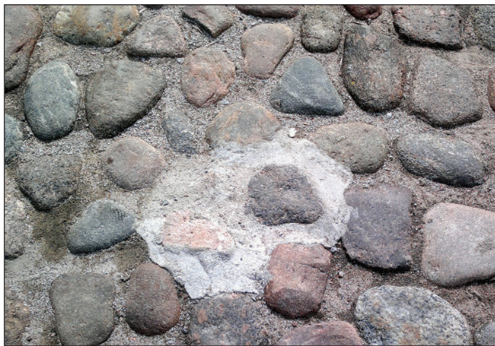
Рис. 57. Закрепление булыжных камней с помощью цемента-песчаного раствора не является эффективным
