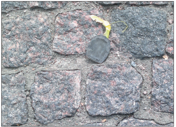
Рис. 3. Незаполненные швы ухудшают эксплуатационные и эстетические качества мощения
