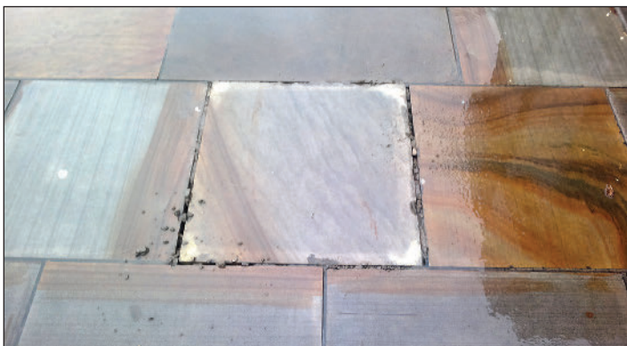
Рис. 9. Крупные плиты не устойчивы в покрытии
