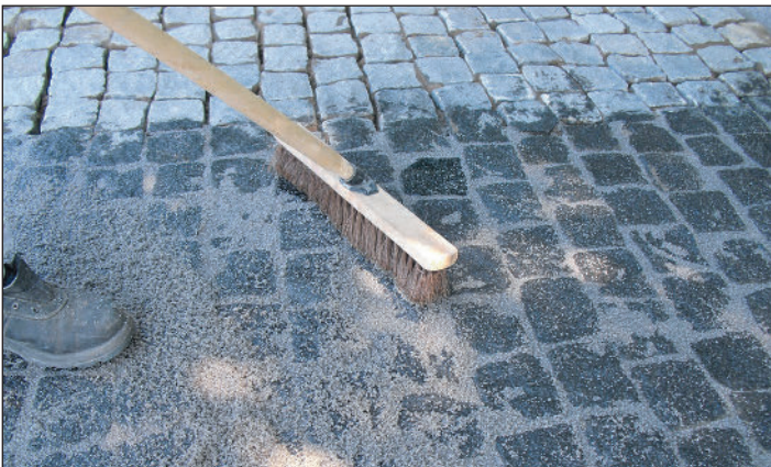
Подметание поверхности мощения щеткой
