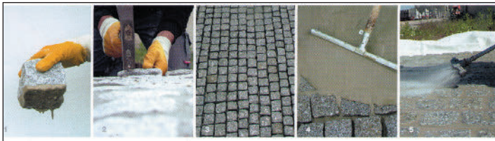
Рис. 32. Пример применения растворов на основе трассово-цементных вяжущих при мощении естественными каменными материалами
