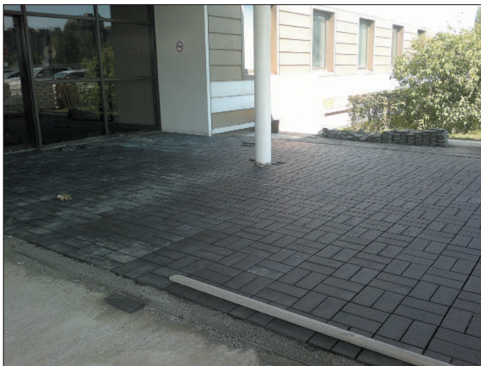
Рис. 69. Мощение входных групп в административное здание. Табачная фабрика "Петро". Процесс выполнения работ. Укладка клинкера на подстилающий слой.
