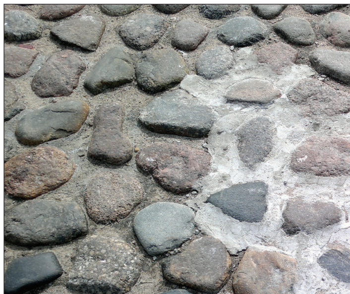
Рис.10. Неудовлетворительное мощение из гранитной шашки и булыжного камня из-за отсутствия сортировки камней
