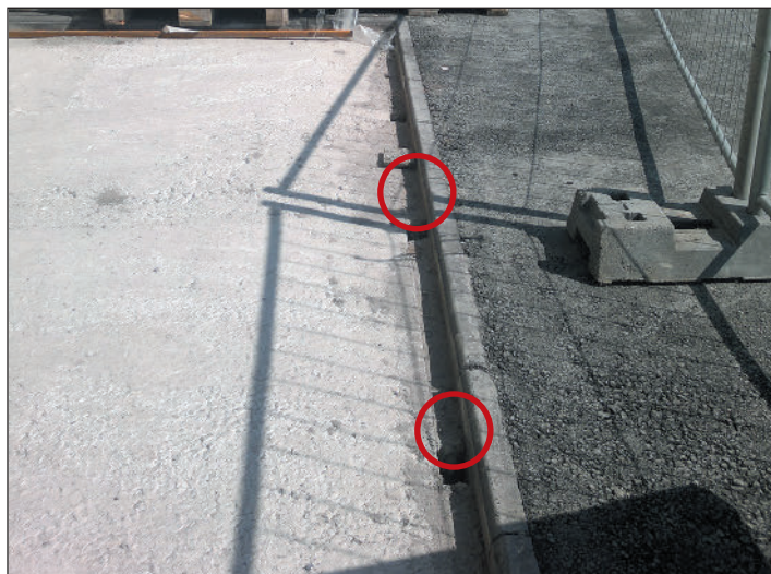
Рис. 15. Устройство внутренних водосборных воронок с отводом воды в дренажный слой конструкции дорожной одежды при мощении на бетонное основание.
