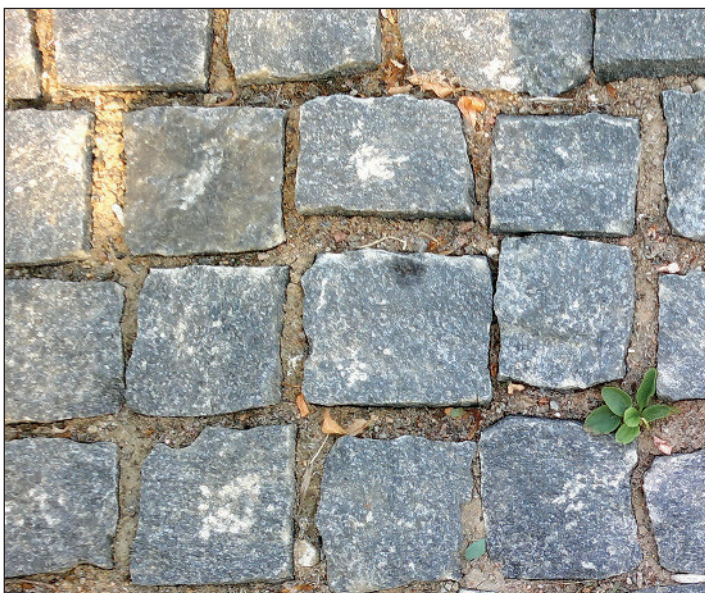
Рис.10. Неудовлетворительное мощение из гранитной шашки и булыжного камня из-за отсутствия сортировки камней
