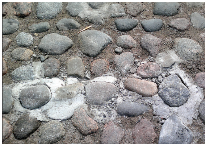
Рис. 57. Закрепление булыжных камней с помощью цемента-песчаного раствора не является эффективным
