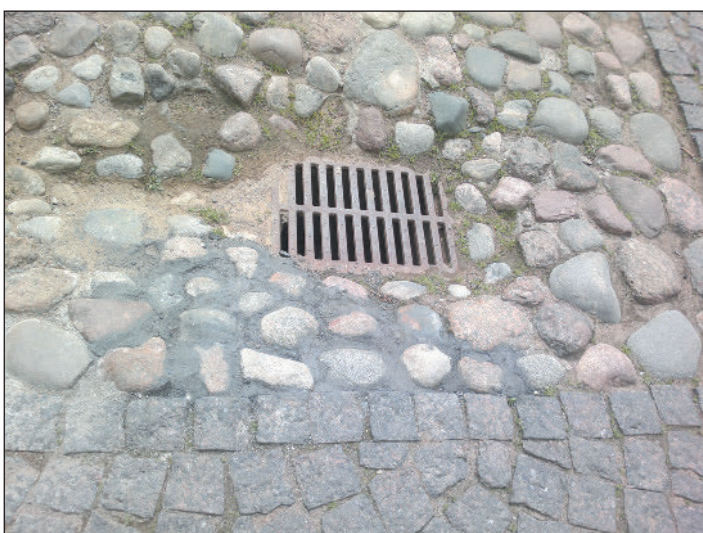
Ремонт мощения, примыкающего к водосборному колодцу.
