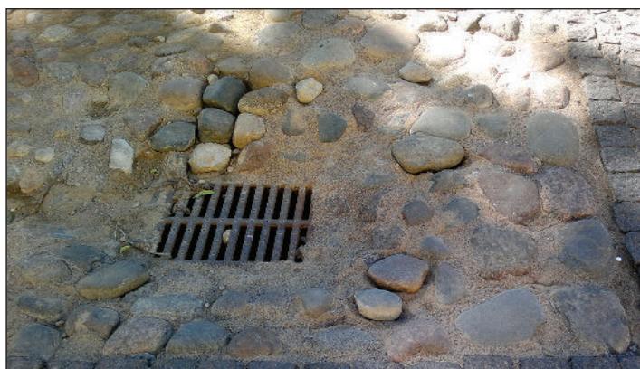
Рис. 54. Мощение булыжником. Процесс выполнения работ (2007 г.)
