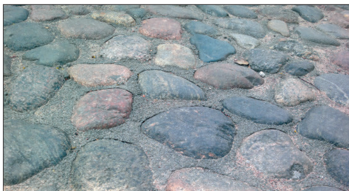
Весна 2014 г. Общий вид и фрагмент покрытия. С покрытия "ушел" характерный блеск от применения растворов на основе вяжущих из эпоксидных смол. Булыжные камни открытого водосборного лотка, которые не были закреплены растворами вывалились из покрытия (вверху фото).
