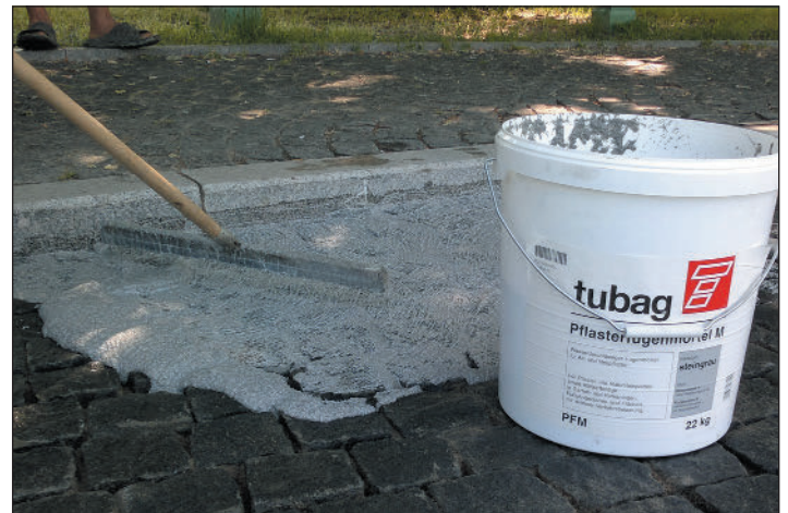
Распределение по поверхности дорожного покрытия водопроницаемого раствора PFM с тщательным заполнением швов
