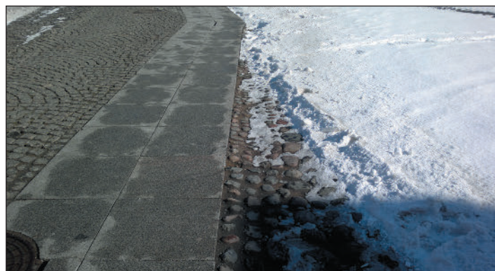
Рис. 59. Зимняя уборка участка мощения, выполненного с применением растворов на основе вяжущих, не вызывает проблем с материалом заполнения швов, который при традиционном исполнении конструкции выносится из покрытия.
