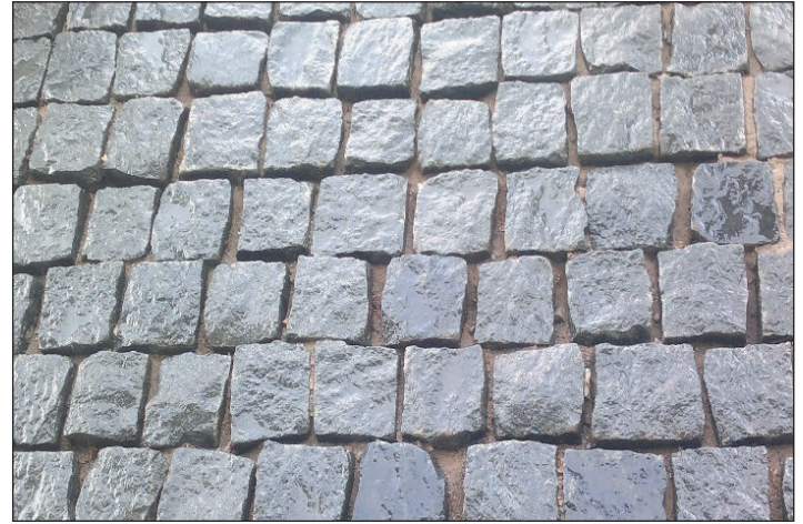
Расшивка швов на глубину не менее 30 мм
