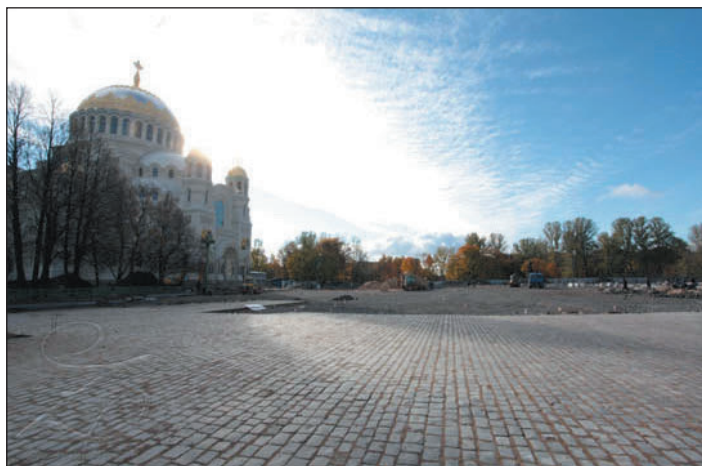
Рис. 75. Мощение северной части Якорной площади
