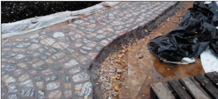
Рис. 31. Отсутствие воздушного зазора между урывочным материалом и мощением привело к образованию белых налетов на покрытии.
