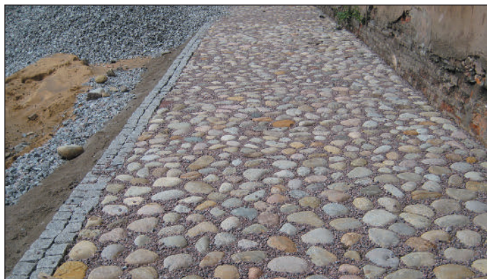
Рис. 52. Мощение булыжником. Процесс выполнения работ (2007 г.)
