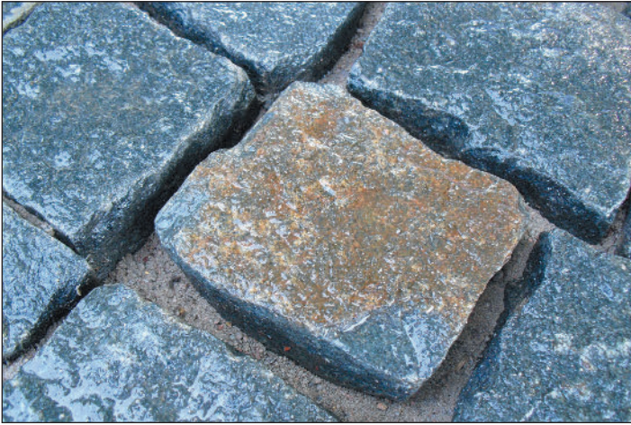
Расшивка швов на глубину не менее 30 мм
