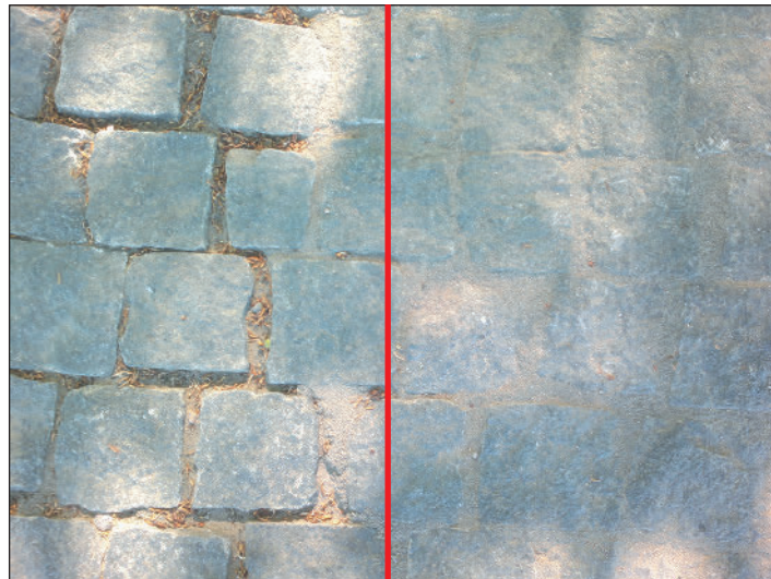
Рис. 77 (б). Швы с заполнением песком (традиционное исполнение, левая часть снимка) и растворами на основе вяжущих (правая часть снимка). Лето 2014 г.
