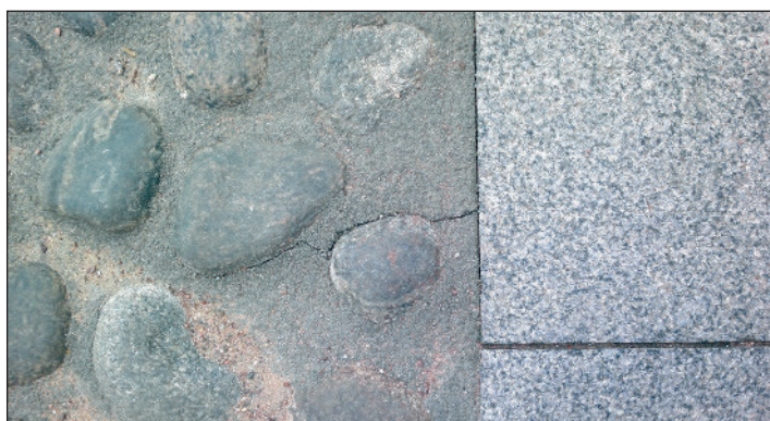
Весна 2014 г. Трещины по примыканию к крупногабаритным гранитным плитам. Плиты плохо прилегают к основанию и расшатываются при проезде обслуживающего автотранспорта. Однако применение растворов позволило зафиксировать край плиты. Трещина больше не развивалась.
