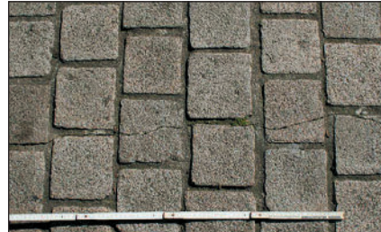
Рис. 20. Трещины в связанных покрытиях от температурных напряжений.
