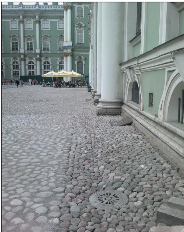
Рис. 51. Производство работ и фрагменты готового покрытия. Белый налет на мощении свидетельствует о недостаточно хорошей смывке шовного раствора.
