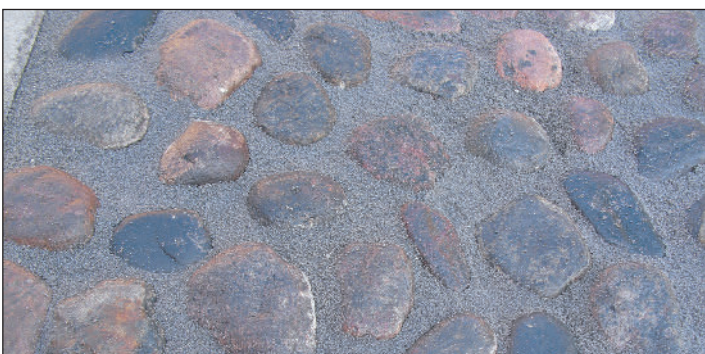
Вид мощения после заполнения швов
