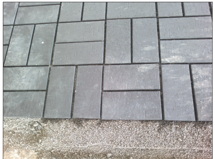
Рис. 69. Мощение входных групп в административное здание. Табачная фабрика "Петро". Процесс выполнения работ. Укладка клинкера на подстилающий слой.
