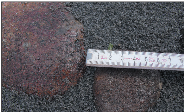
Увеличенные швы способствуют большому расходу раствора
