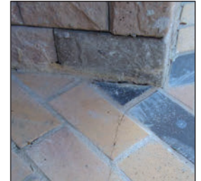
Рис. 20. Трещины в связанных покрытиях от температурных напряжений.
