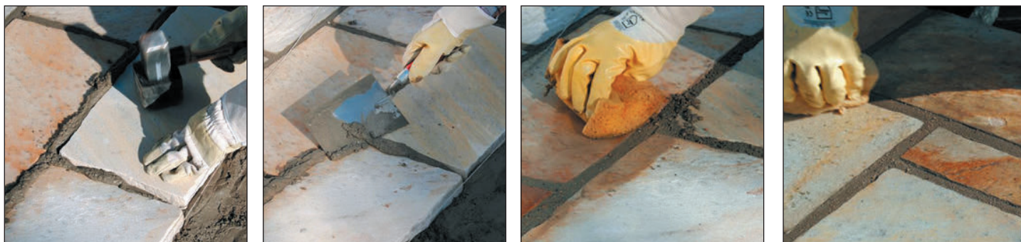
Рис. 43. ПМощение с применением растворов NVL.
