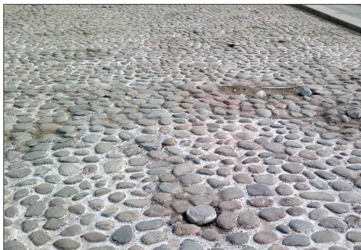
Рис. 56. Мощение булыжником. Процесс выполнения работ (2007 г.)
