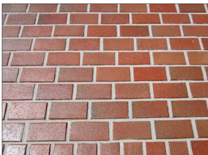
Рис. 62. Дорожная одежда с покрытием из клинкерного кирпича с использованием растворов на основе вяжущих:
