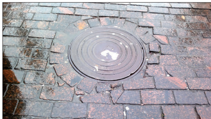
Рис.11. При мощении не соблюдаются правила выполнения примыканий
