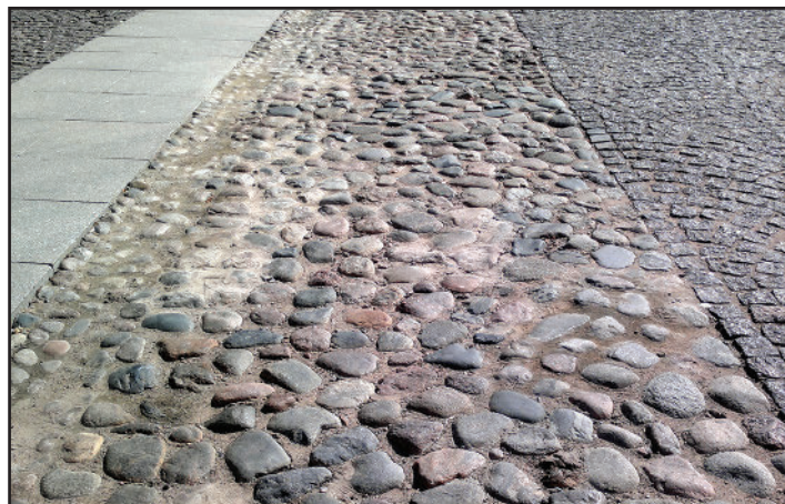
Рис. 58. Расположение и общий вид участка мощения для демонстрации растворов. На фото слева вдоль гранитных плит виден водосборный лоток
