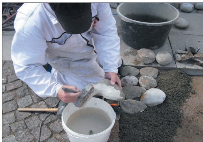
Обработка основания булыжника адгезионным раствором
