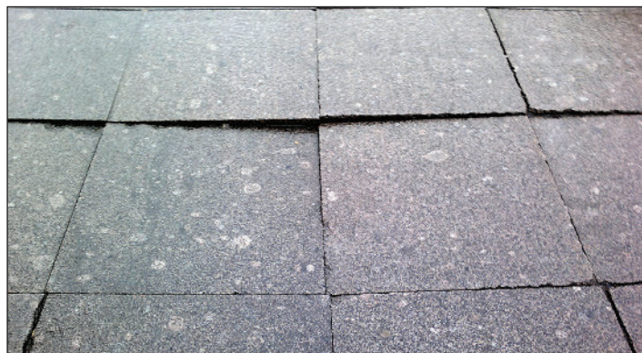
Рис. 9. Крупные плиты не устойчивы в покрытии
