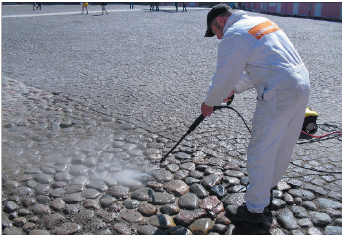
Расшивка швов факелом воды под высоким давлением
