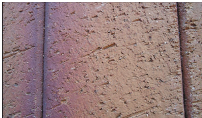
Рис. 38. Раковины на лицевой поверхности клинкера
