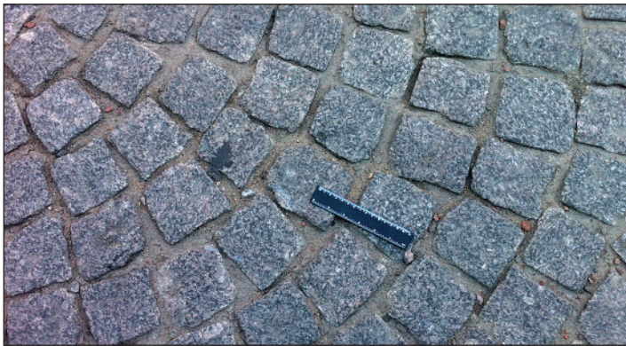
Рис. 8. Мощение по дугам из гранитной шашки. Швы 20-30 мм.
