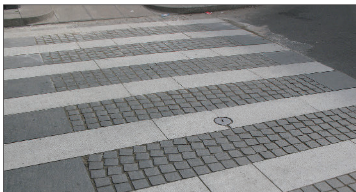
Рис. 6. Разрушение мощения наземного пешеходного перехода на участке автомобильной дороги
