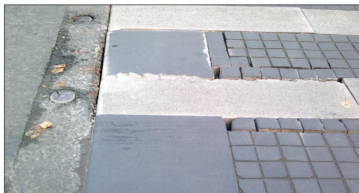
Рис. 6. Разрушение мощения наземного пешеходного перехода на участке автомобильной дороги
