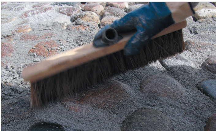
Очистка булыжника. Удаление остатка раствора щеткой
