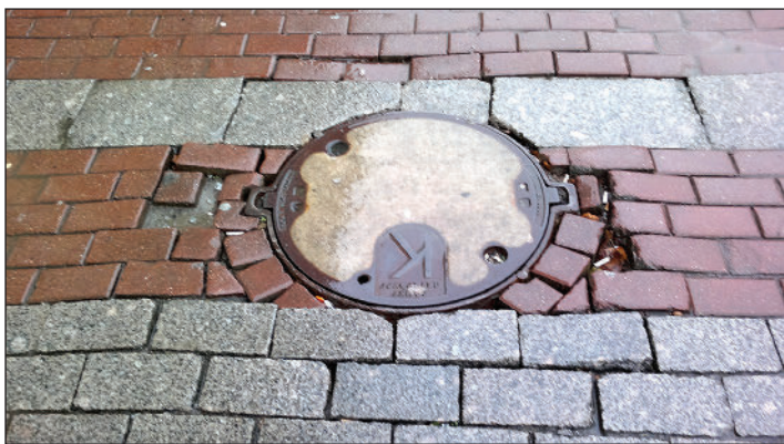
Рис.11. При мощении не соблюдаются правила выполнения примыканий
