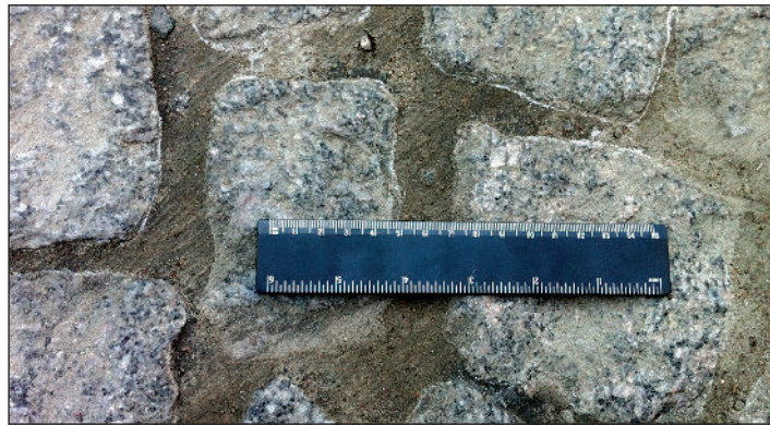
Рис. 8. Мощение по дугам из гранитной шашки. Швы 20-30 мм.
