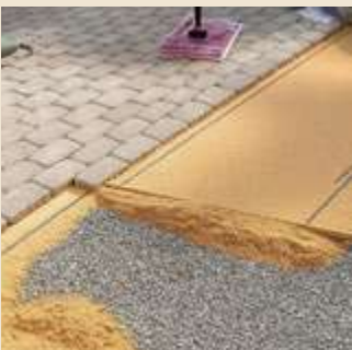
6. Устройство подстилающего слоя: песок кварцевый мытый крупный, гранитный отсев
