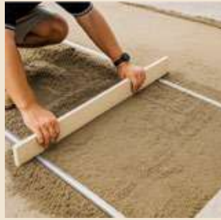
3. Устройство выравнивающего песчаного слоя
