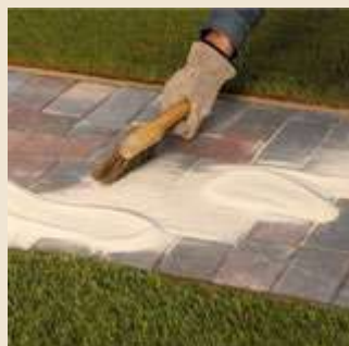
8. Заполнение швов материалами с высокой водопроницаемостью: Tubag PFL (Quick-Mix), или чистый кварцевый песок фракции 0-2 мм
